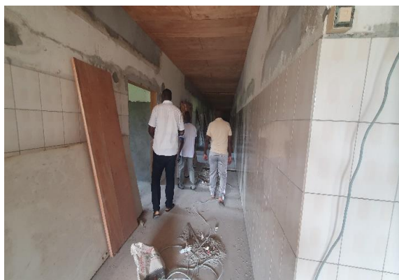
Vue du couloir principal (avant)
