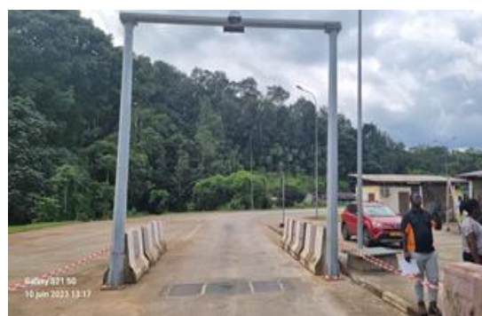
Vue de la station de pesage de Ndjolé
