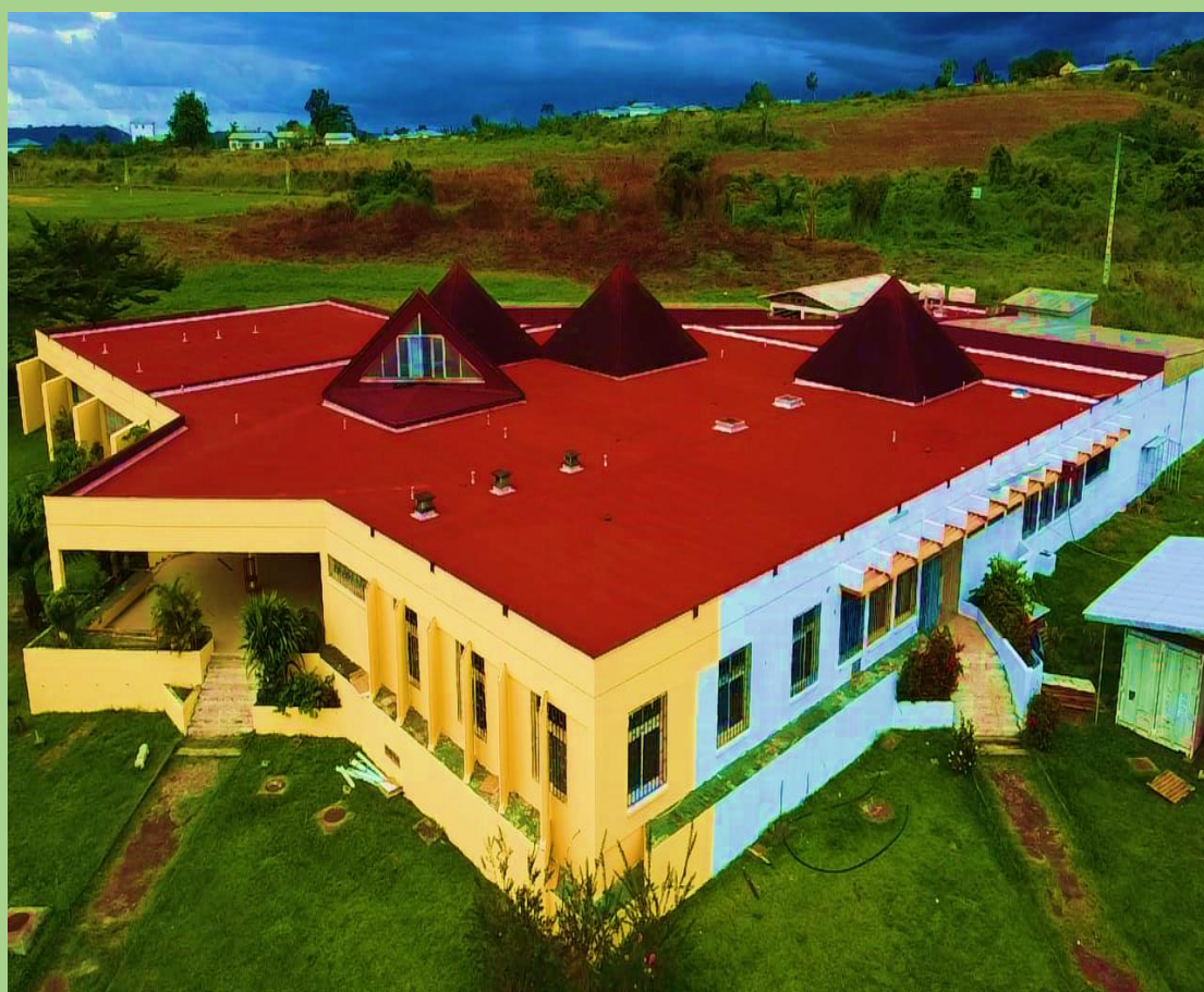
Restaurant de l'Université des Sciences et Techniques de Masuku (USTM) en cours de réhabilitation
